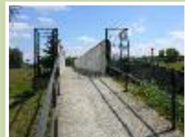
La passerelle provisoire installée depuis le début des travaux a donc été démontée.
